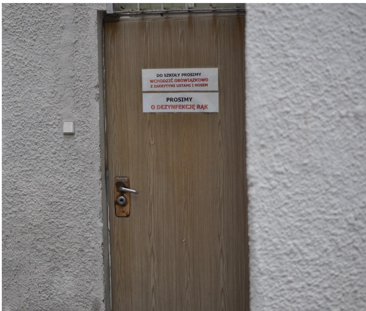
Zdjęcie przedstawia wejście do szkoły od ulicy Waryńskiego (przejście w świetle budynku nr 8-8A od podwórka).
